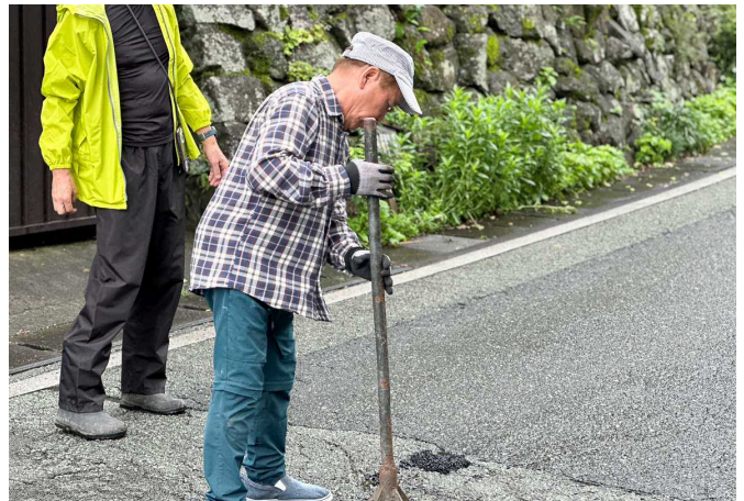
「しごとコンビニ」での道路補修業務の様子
